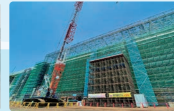
2022年6月19日 北陸新幹線敦賀駅新築工事上棟式
